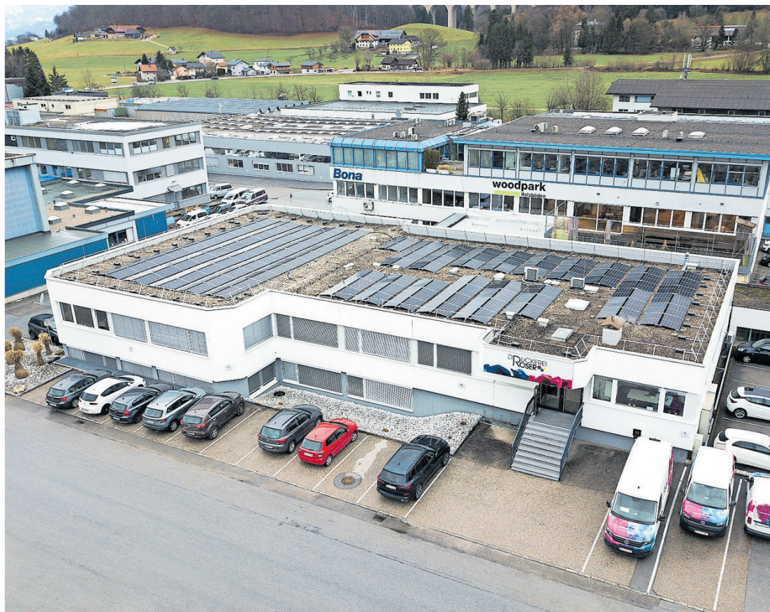
Die Druckerei Roser beliefert am Wochenende ihre Nachbarn mit überschüssigem Strom aus der PV-Anlage.
